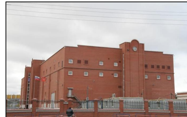
Строительство ПС «Волхов-Северная»
