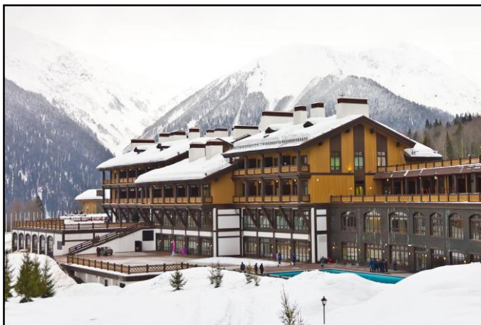
Электроснабжение горнолыжной базы «Лаура»
