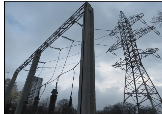
Вынос ВЛ 110 кВ Ржевская 3/4
