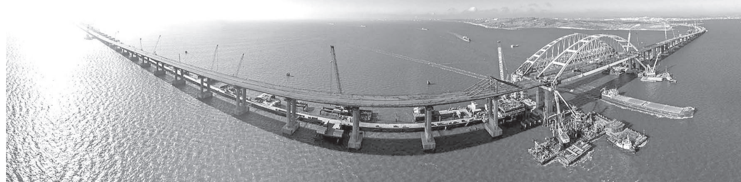
В феврале строители Крымского моста приступили к устройству железнодорожных пролетов над акваторией Керченского пролива. В этой грандиозной стройке есть вклад ООО «Камский кабель». Фото с сайта www.most.life
