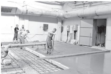
На этой неделе под контролем специалистов ОКСиР произведено бетонирование производственных полов и фундаментов под оборудование с последующим упрочнением топпингом
