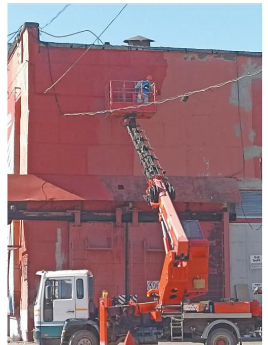
Усиление плит покрытия зданий выполняется с применением инновационного углеродного волокна. После восстановления геометрии плиты выполняется антикоррозионная защита арматуры, наносится противопожарный состав, приклеивается углеволокно. Этот легкий, современный, долговечный материал применяется в авиации. Он облегчает вес наших строительных конструкций, позволит эксплуатировать корпуса еще долгие годы.
