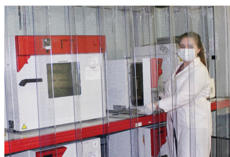
Обновленная вентиляция в ЛКИ ЦЗЛ выполняет и защитные функции
